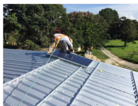
Công trình nhà Chị Hồng - Sơn Tây
