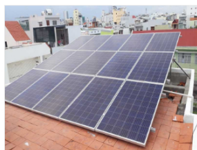
Công trình nhà Anh Nam - Lào Cai
