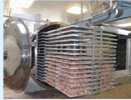
Lắp đặt máy sấy đồng khô công nghiệp Airconz ACZ1000 cho nhà máy sản xuất
