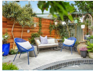
Thiết kế và thi công khuôn viên vườn sân thượng nhà phố
